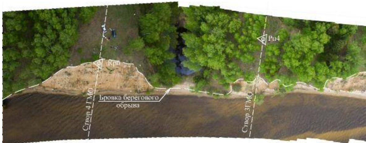
Рис. 6. Результаты аэрофотосъемки участка левого берега Горьковского водохранилища у д. Вашуриха
