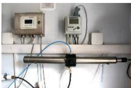
Датчик УФ спектральный нитратного и нитритного азота с автоочисткой, NiCaVis705Ni
