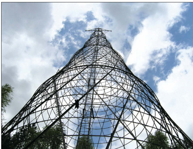
Бывшая опора ЛЭП НигРЭС на берегу р. Оки у г. Дзержинска
