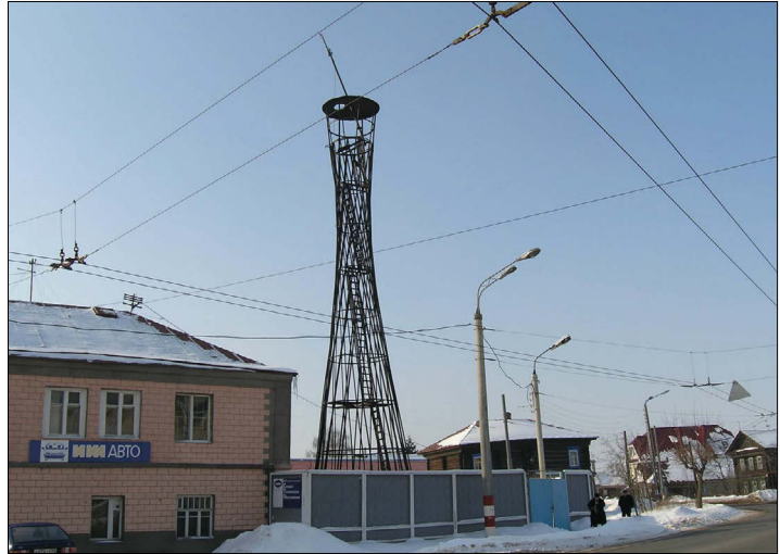
Бывшая смотровая вышка пожарной части, г. Нижний Новгород, Сормово, ул. КИМа, 86
