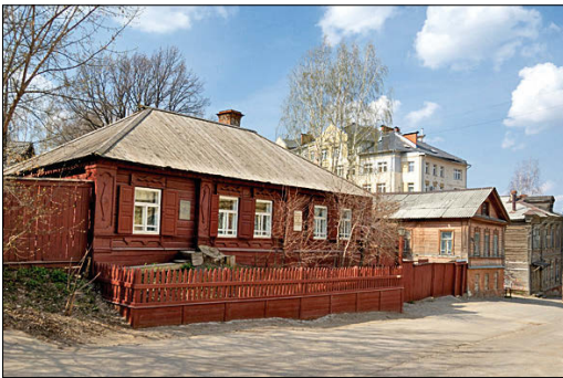
Фрагменты застройки Ильинской слободы
